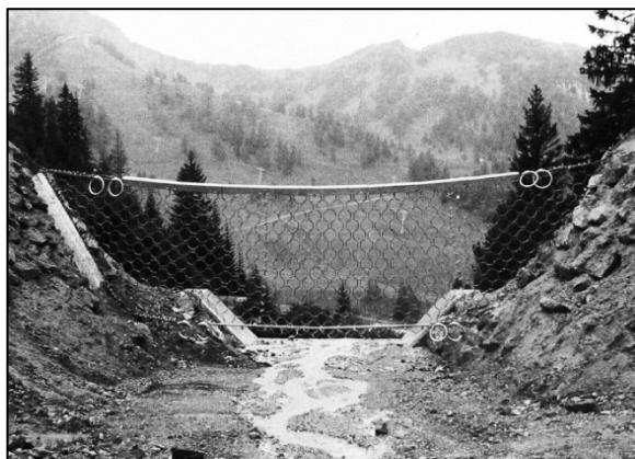
Рис. 2. Противоселевой барьер из сетки ROCCO (кольца сплетены из стальной проволоки), длина конструкции 15м, высота 4м, объем задерживаемой массы 4000м 3
